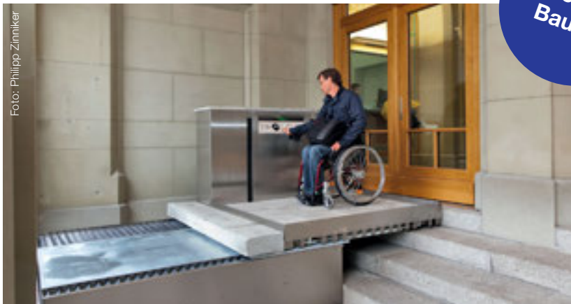
Ein Hebe-Schiebe-Lift ermöglicht den Zugang zum Bundeshaus West.
